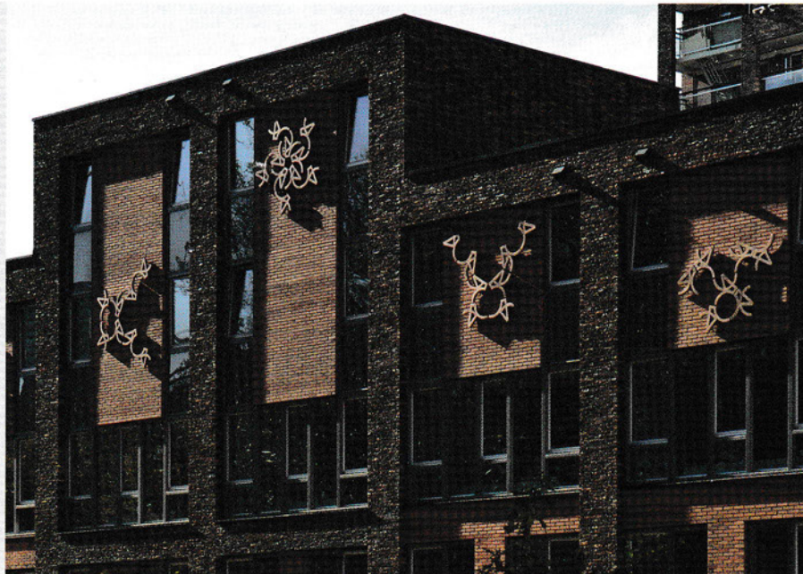
Christine Jetten / Joris Molenaar, ArchiRelief - Identiteit in Architectuur door Ornament en Reliëf. Gevelornamenten wederopbouwwijk Poptahof, Delft, 2010/11.
